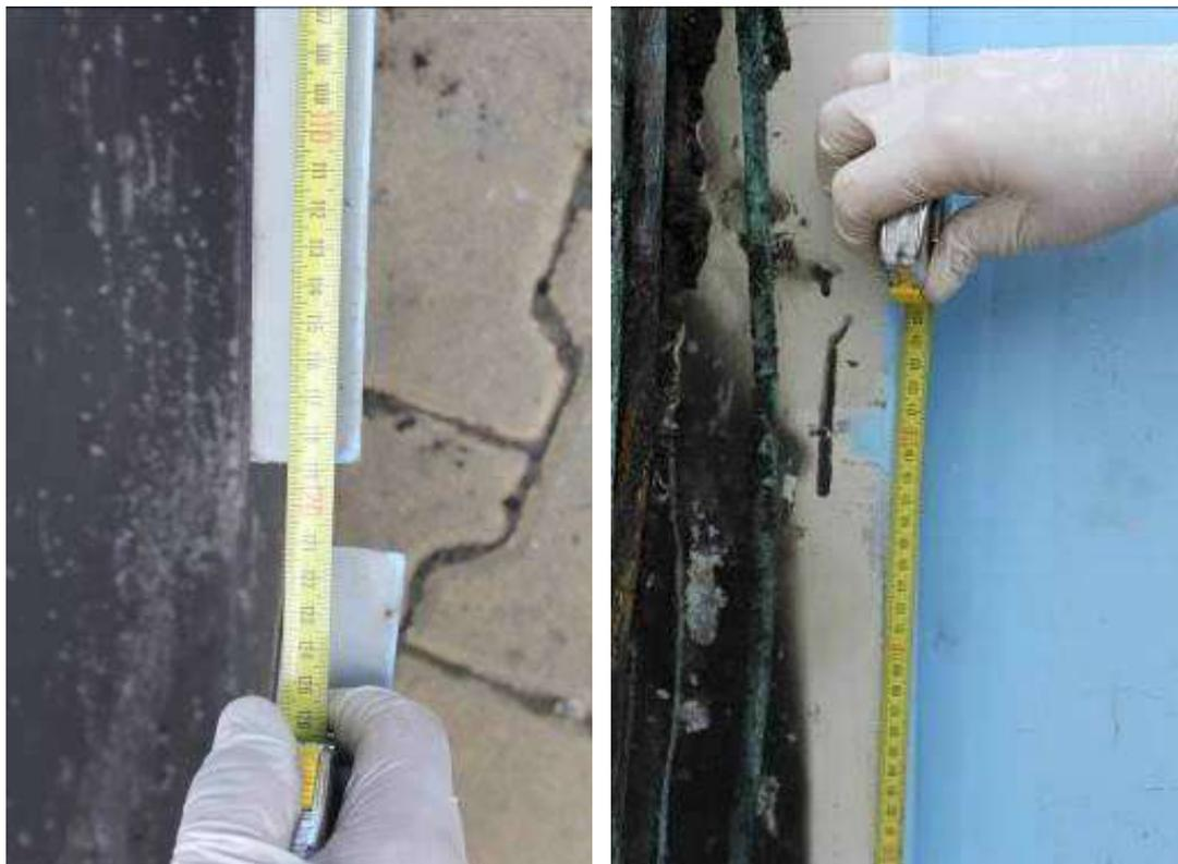
Si provvedeva, inoltre, ad analizzare la parte interna della lamiera che componeva il cavedio tecnico, osservando segni di un marcato danneggiamento termico nella parte bassa, corrispondente alla quota pavimento.
