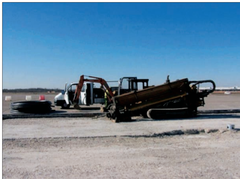
Fig. 5: Perforatrice montata su carro cingolato (Fonte 1)
