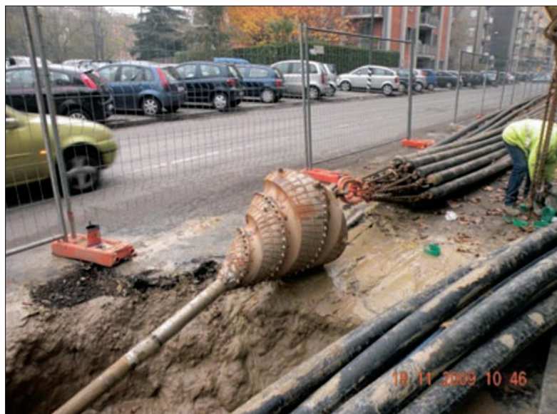
Fig. 9: Alesatore che trascina serie di tubi all'interno del foro partendo dal pozzo di arrivo (Fonte 1)
