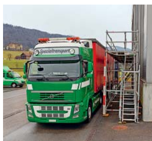
1 Ponteggio impiegato per lo sgombero di neve e ghiaccio
