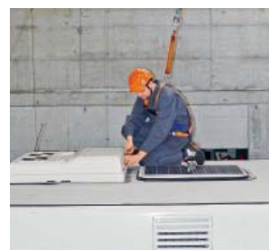
4 Protezione con DPI anticaduta sul tetto di un bus
