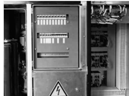
Foto 15: una copertura isolante impedisce il contatto diretto quando l'armadietto è aperto
