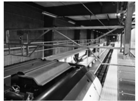
Foto 10: dispositivo anticaduta sul lato frontale del veicolo
