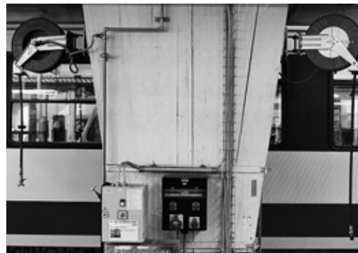
Foto 1: una bobina avvolgicavo mantiene l'ordine ed elimina gli ostacoli.
