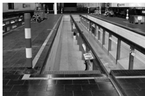
Foto 3: bordi della fossa correttamente segnalati chiaramente in giallo
