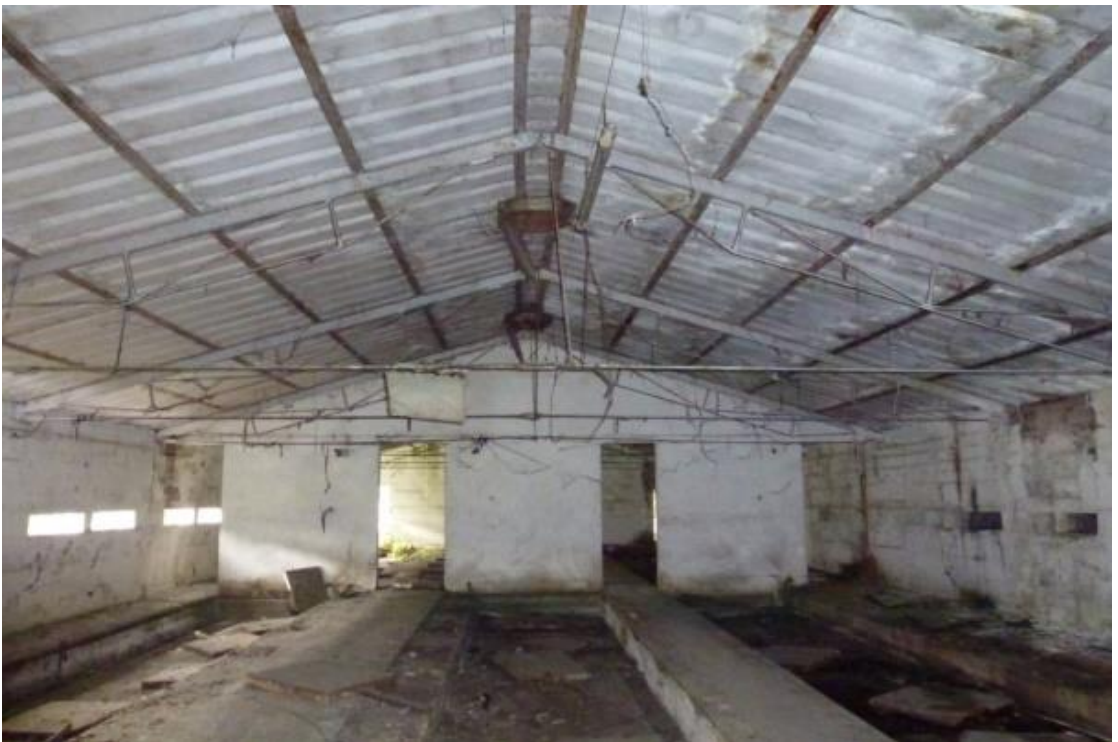
Figura 2 - Sito produttivo con coperture da bonificare.
