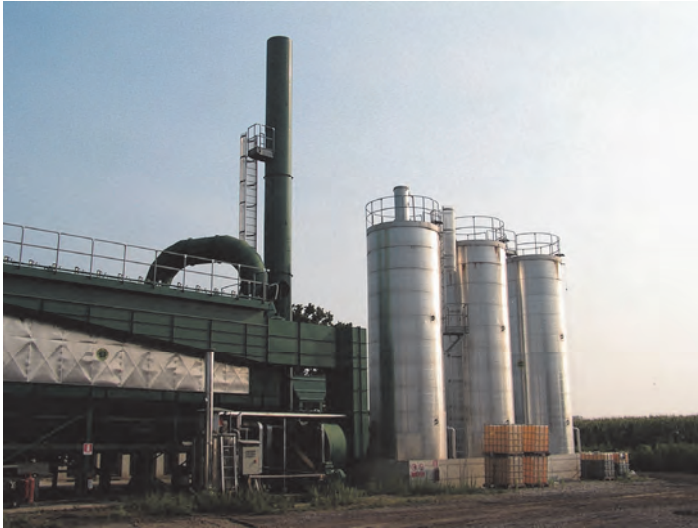
Figura 15 - Stoccaggio filler nello stabilimento di produzione
