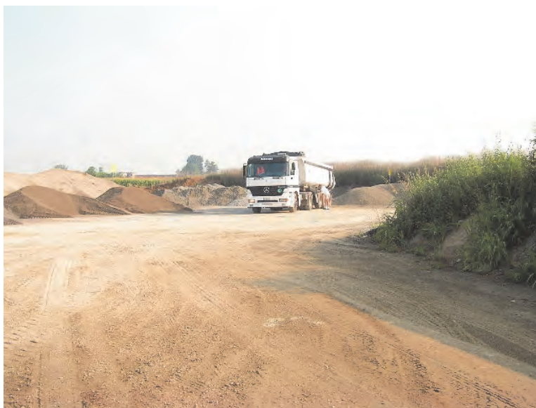
Figura 13 - Arrivo inerti allo stabilimento di produzione
