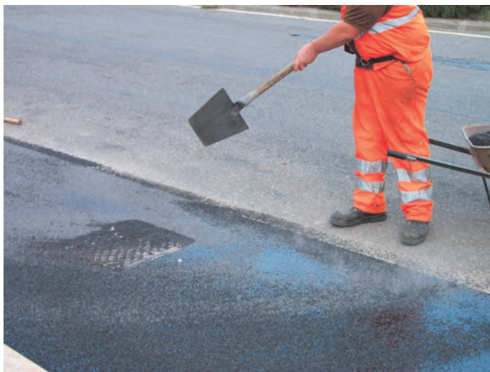
Figura 35 - Spargimento di sabbia su marciapiede
