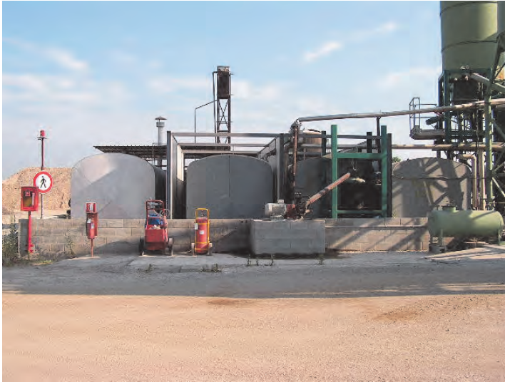
Figura 16 - Stoccaggio bitume nello stabilimento di produzione
