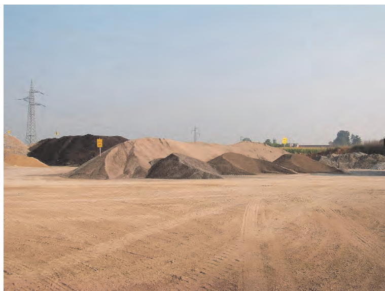
Figura 14 - Stoccaggio inerti nello stabilimento di produzione
